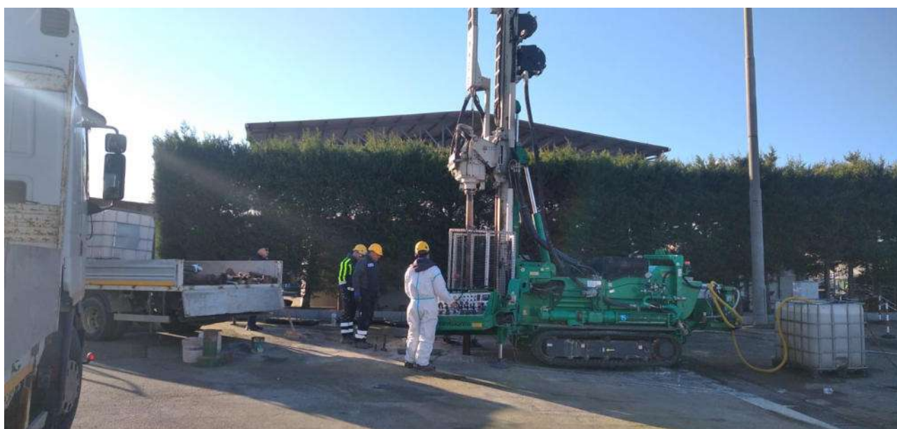
Foto 1-Sondaggio geognostico eseguito nel lotto
